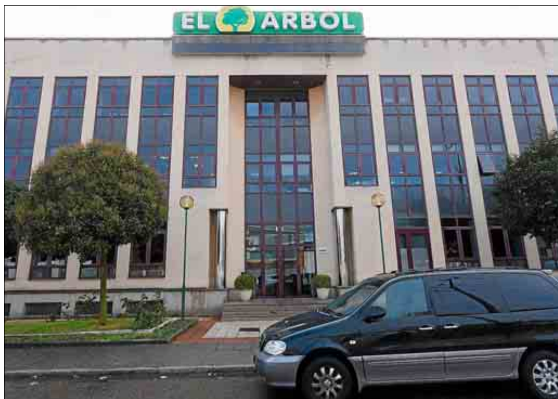
Sede central de El Árbol en el Polígono de Argales de Valladolid. EL MUNDO
