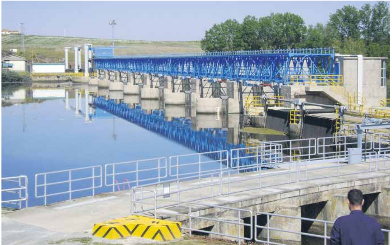
Compuertas de Villagonzalo. ❖ CHD
