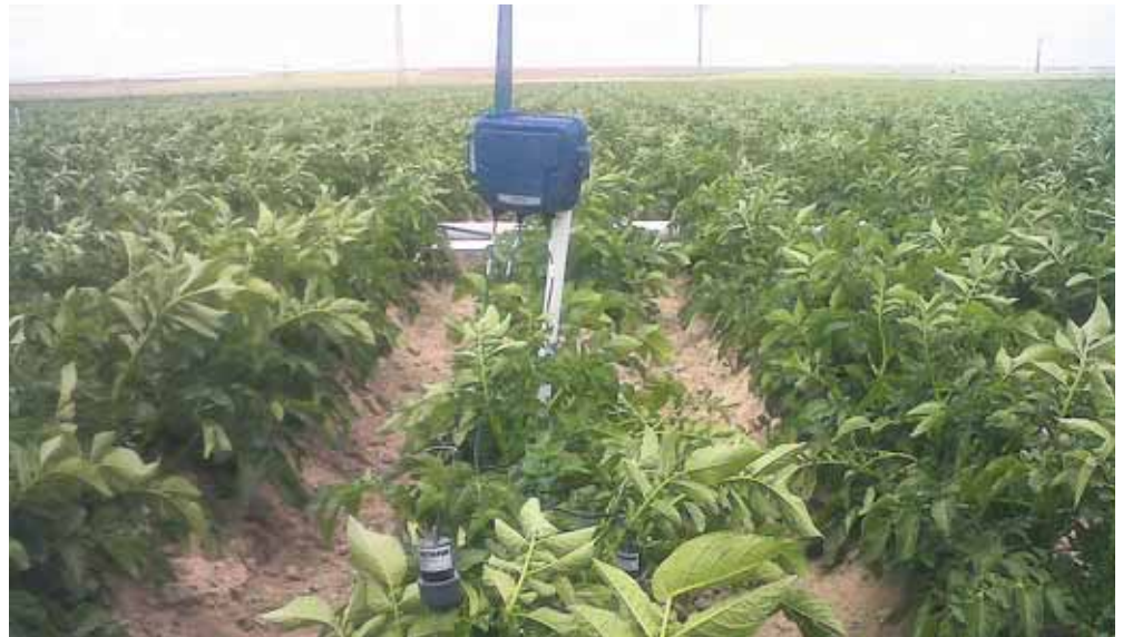
El uso de sondas es de gran utilidad para regular la fertirrigación.
